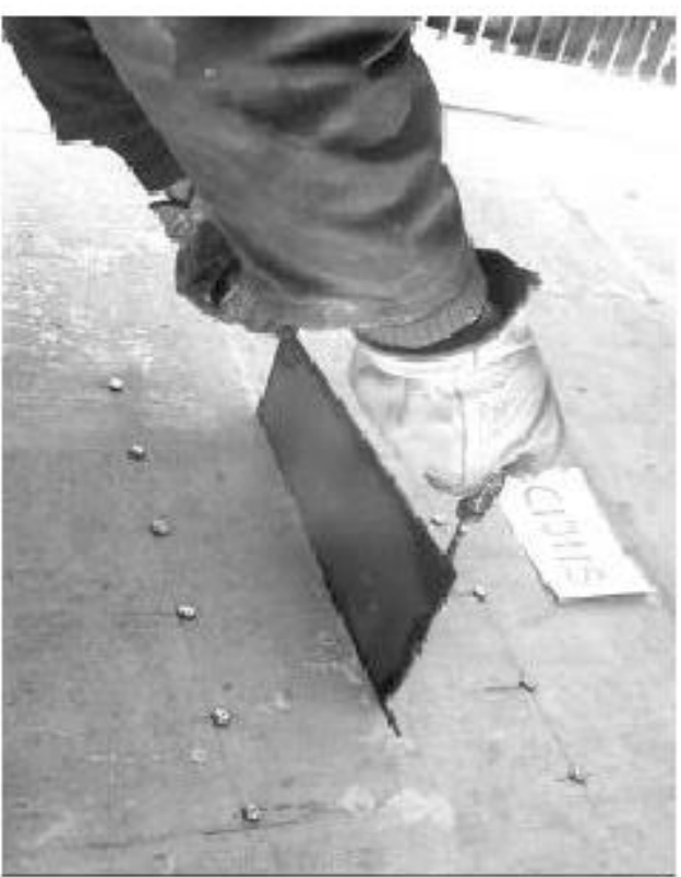
Fig. 13. Posizionamento di un martinetto.
